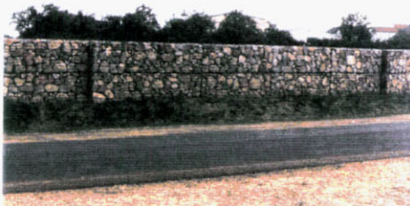
Eksempel på mur bygget af stengabioner
